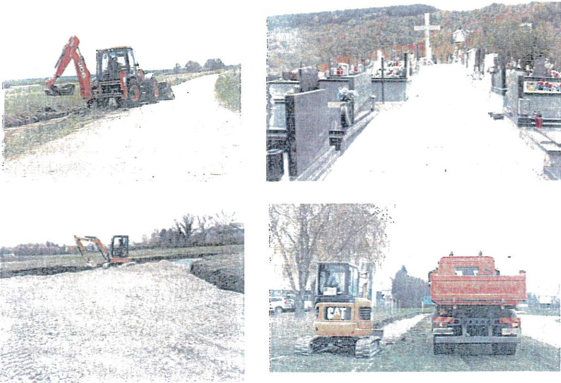
Radovi u Cvetkoviću, Dragovanščaku, Južnoj zoni i GZ »Jalšovec«
