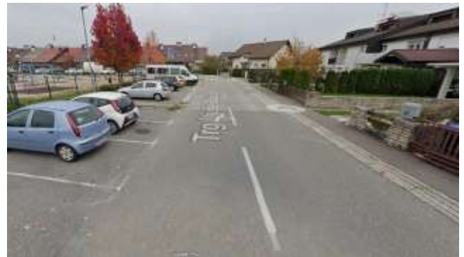
Slika 2: Postojeće stanje OS 5
